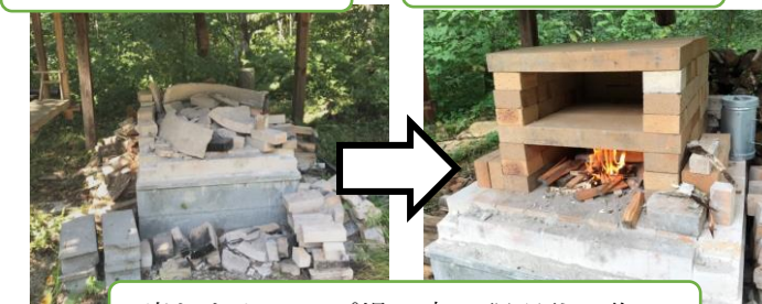
崩れたキャンプ場の森の調理釜の復旧
